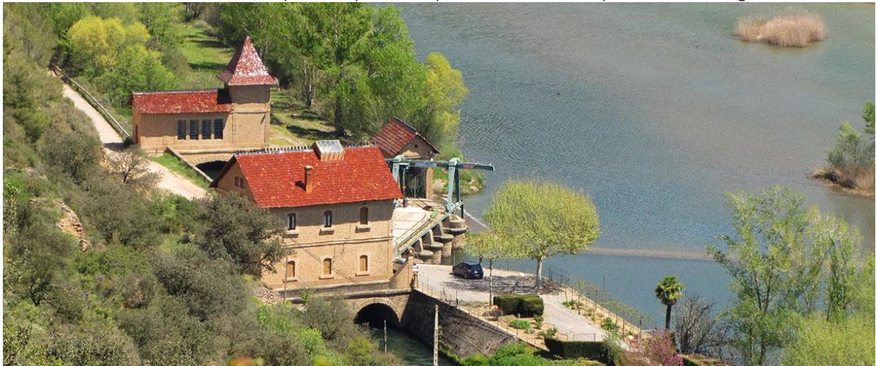
Foto 3. La casa de comportes al punt de captació del canal Principal sobre el riu Segre.
