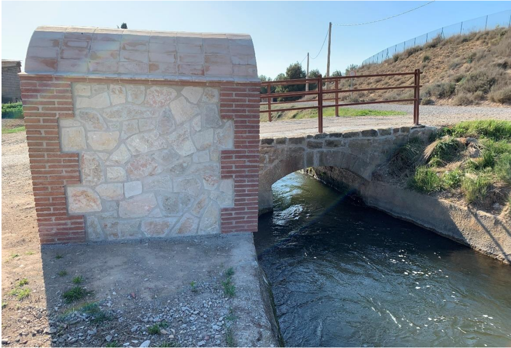
Foto 16. Manteniment i conservació d'elements patrimonials com ponts de pedra i mòduls
