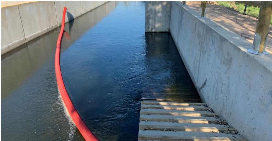
Foto 9. Detall des de la part superior de la rampa de salvament estructural.
