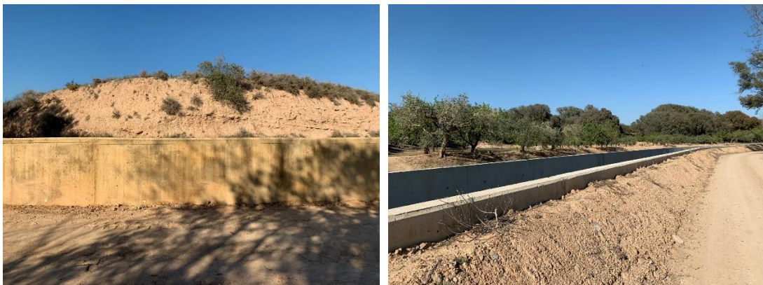
Foto 11. Aspecte d'una estructura de formigó de la primera séquia principal tenyida amb sulfat de ferro i terraplenat per a millorar la integració paisatgística.
