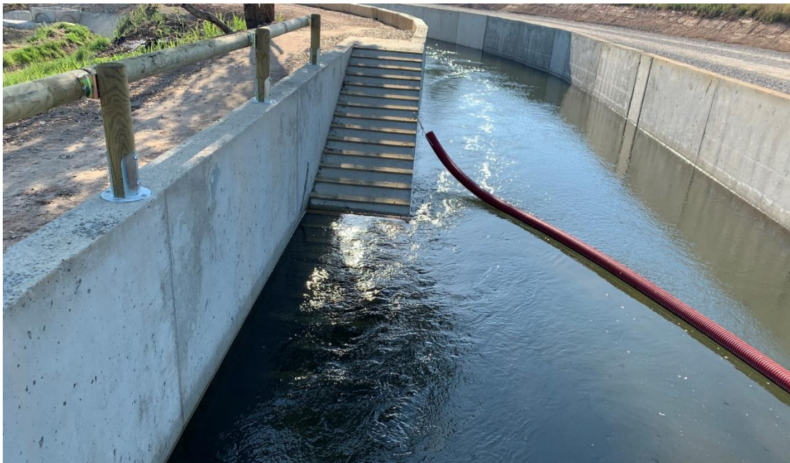
Foto 8. Rampa de salvament estructural annexada a la séquia primera del canal aplicant aquesta proposta.
